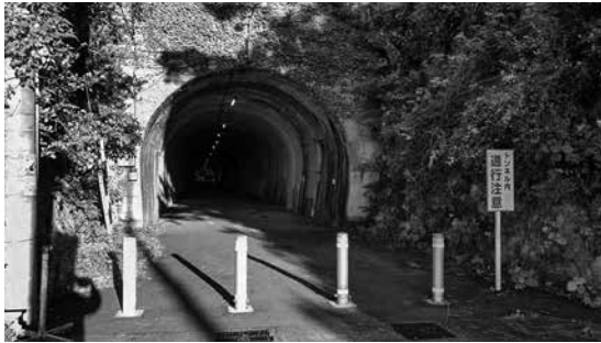
二見のトンネル
