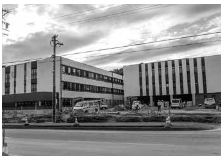
建設中の二見浦小学校・二見中学校
